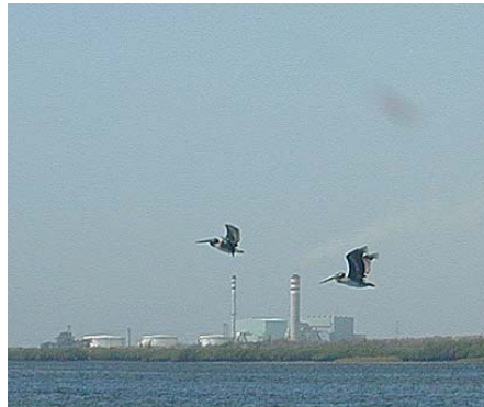
Das Kraftwerk von Puerto San Carlos, Baja California Sur, Mexiko.
